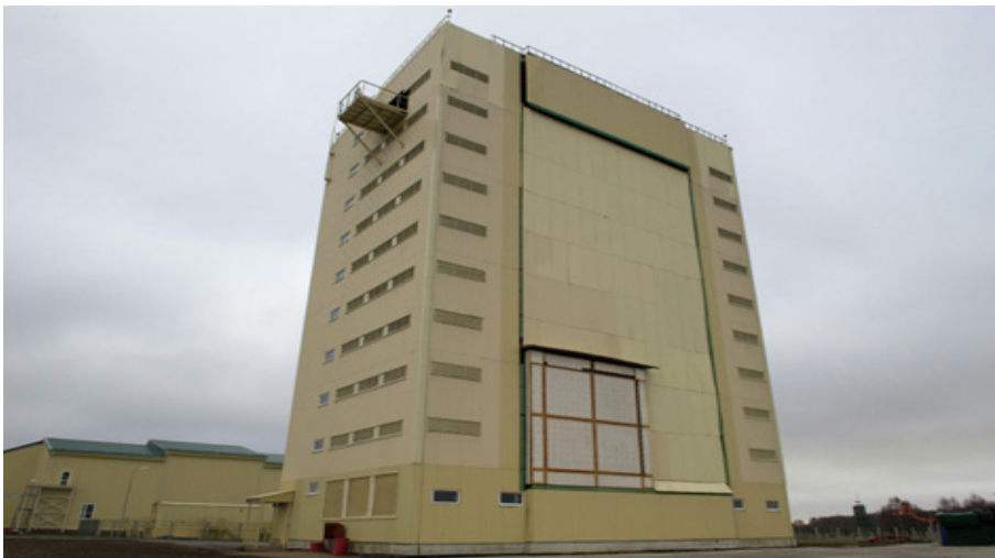
Rys. 2. Radar Woroneż-DM w Pionierskij w obwodzie Kaliningradzkim w trakcie konstrukcji. Tylko około 1/6 powierzchni antenowej obsadzona
